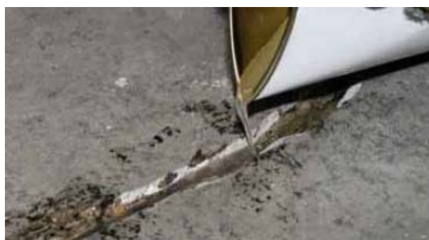
Рисунок 5. Заливка MasterInject 1360 непосредственно в V-образную штрабу на трещине
